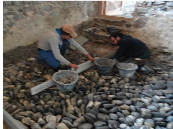
Bild rechts: Einlegung Rollierung
