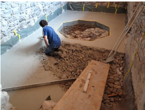
Bild links: Zwischenstand Mörtleinbau
