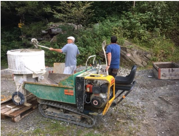
Bild links: Mörtelaufbereitung
