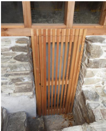
Bild links: Türe fertig montiert
