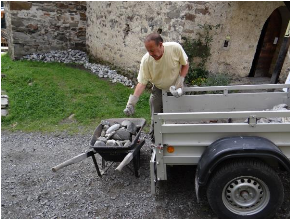
Bild links: Auslese und Antransport Rollierungssteine
