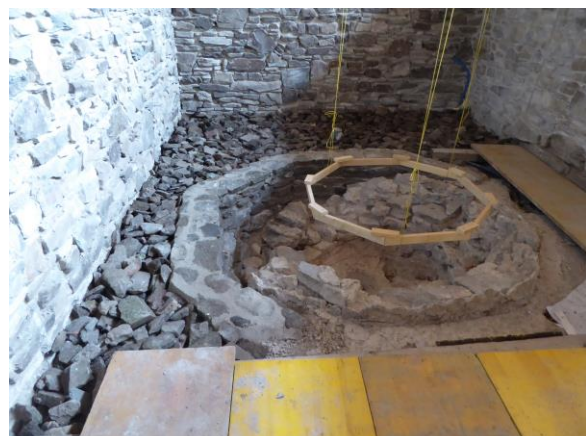
Bild rechts: beendete Aufmauerung und Auffüllung
