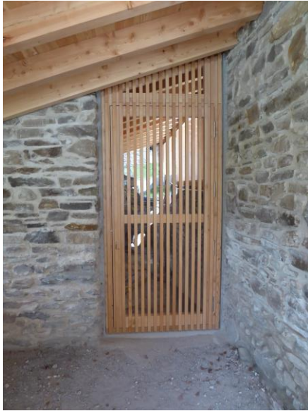
Bild links: fertige Türe montiert
