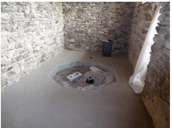
Bild rechts: fertiger Mörtelboden mit Gasheizung
