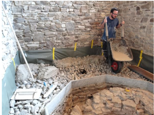
Bild rechts: Mörtleinbringung auf die Rollierung
