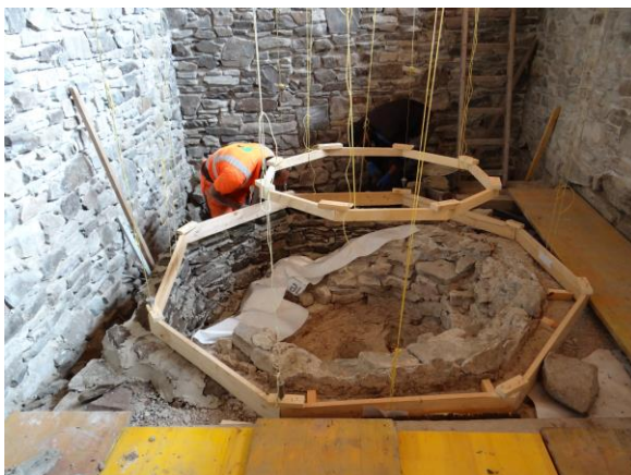
Bild links: Aufmauerung in Arbeit
